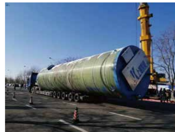
沈阳鞍山雨水泵站
