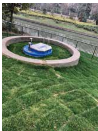
合肥二十埠河治理泵站 日处理量：4800m 3 /D 泵站规格：DN2500*6500
