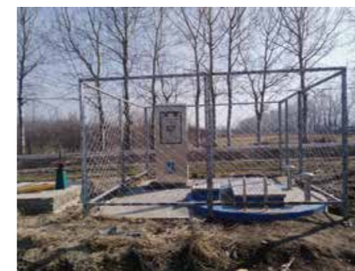
青云店镇泵站
