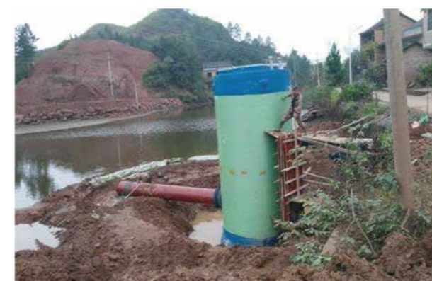
兰州武威湿地公园泵站 日处理量：7600m 3 /D 泵站规格：DN3000*7000
