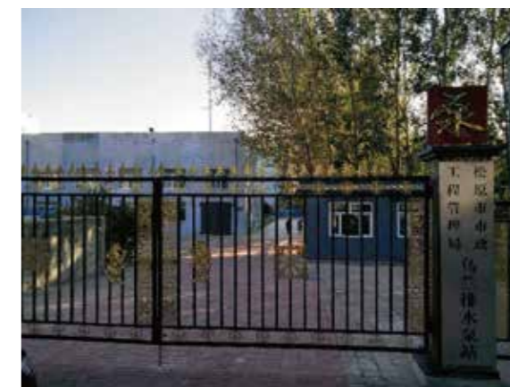
松原市政排水站
